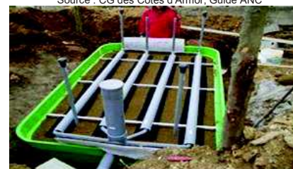
Travaux d'installation d'un filtre à zéolite
