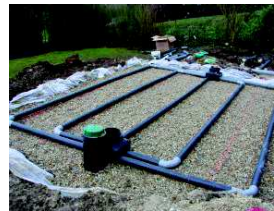
Exemple de travaux pour l'installation d'un système d'assainissement non collectif ©SATESE/CD77
